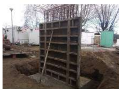
Foto 04 - Acesso coberto: cofragem parede maciça
